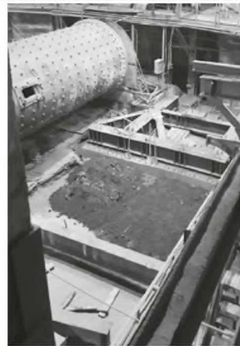
Ведется обустройство фундамента сепараторной установки
