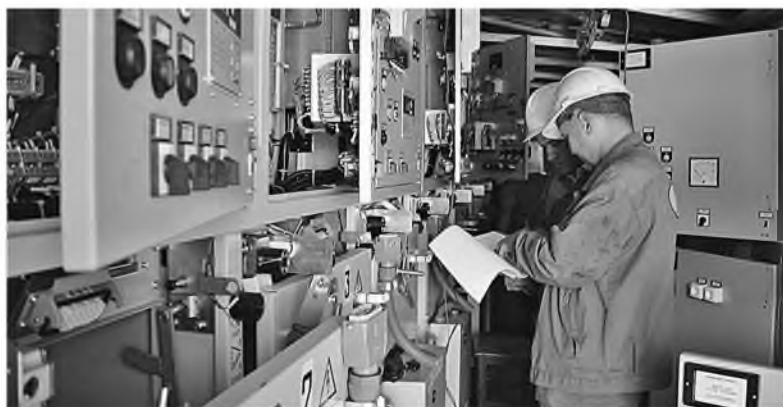
На новую систему электроснабжения цеха уже направлено 32 млн рублей
