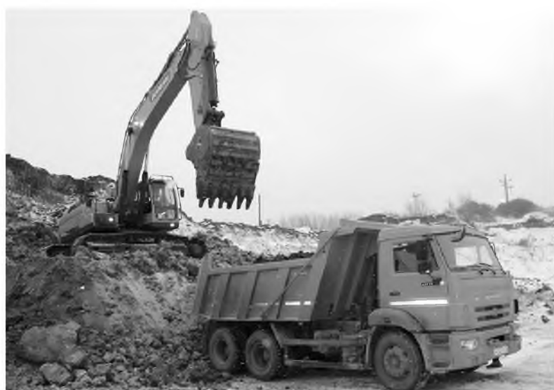
Новый экскаватор уже в работе
