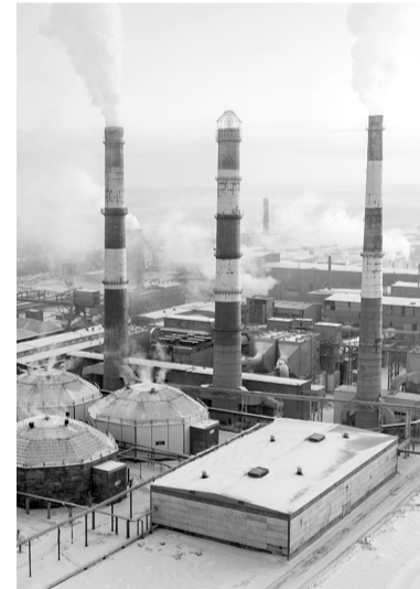
Трубу на время ремонта накрывают «шапочкой»
