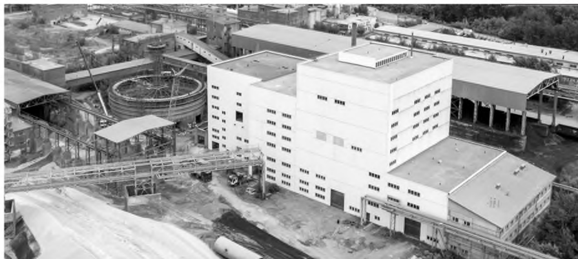
В Красноярске продолжается строительство нового отделения «Помол»
