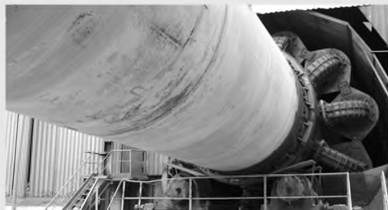
Специалисты провели полноценный ремонт опорной части печи №3
