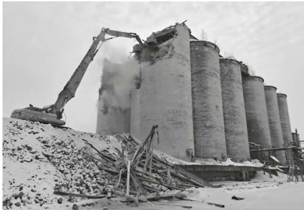
▲ Экскаватор-разрушитель ведет снос цементных силосов с предварительно подготовленной насыпи
