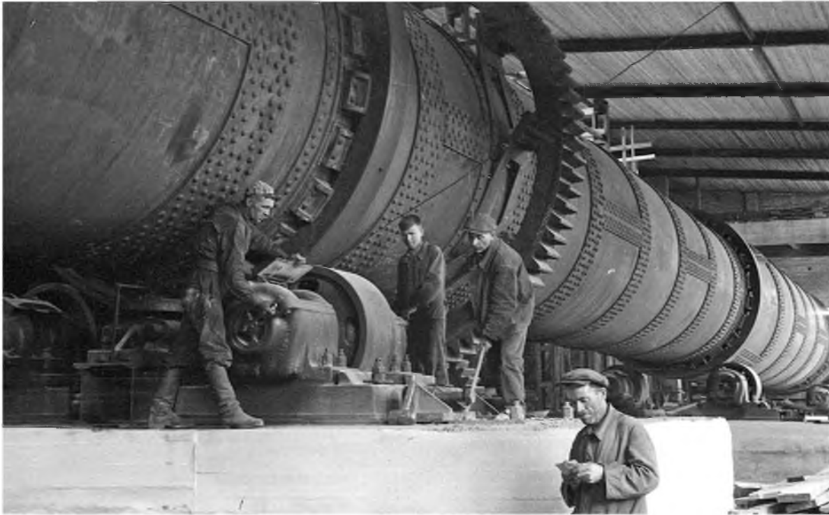
Установка вращающейся печи на Красноярском цементном заводе (1944 год)
