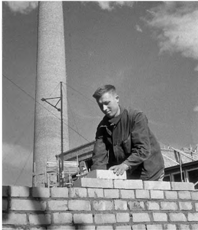
Каменщик-двухсотник Красноярского цементного завода Душейко за работой (1944 год)
