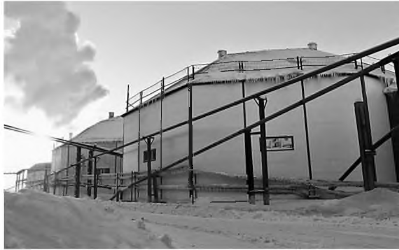
Вместо старых стеновых плит установили белоснежные сэндвич-панели
